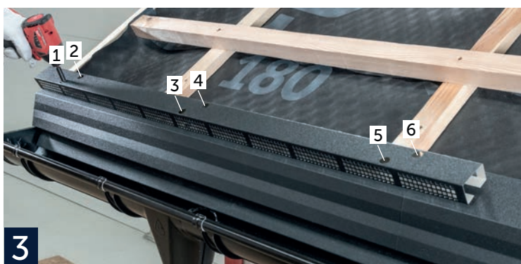
Listwę dokręcamy do łąaty przez pas nadrynnowy za pomocą 6 sztuk wkrętów farmerskich 4,8x35 przez specjalnie przygotowane do tego celu otwory montażowe [1-6].
