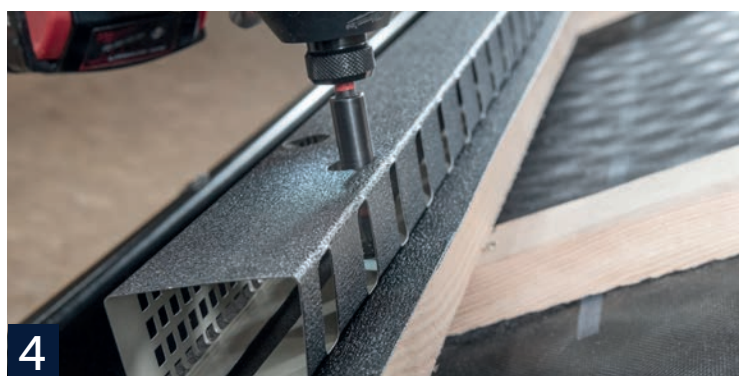
Listwę dokręcamy do łąaty przez pas nadrynnowy za pomocą 6 sztuk wkrętów farmerskich 4,8x35 przez specjalnie przygotowane do tego celu otwory montażowe [1-6].
