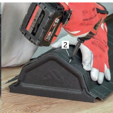
3 Po vyvrtání spojte hřeben s koncovkou farmářskými šrouby [1], [2] nebo lakovanými nýty.
