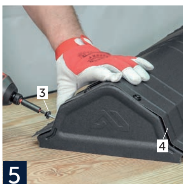
5 Po vyvrtání spojte hřeben s koncovkou pomocí dvou dalších šroubů [3], [4] nebo lakovaných nýtů.
