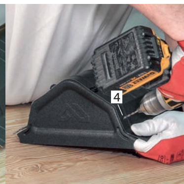
4 Následně vyvrtejte další 2 otvory [3], [4] po obvodu, po bocích.
