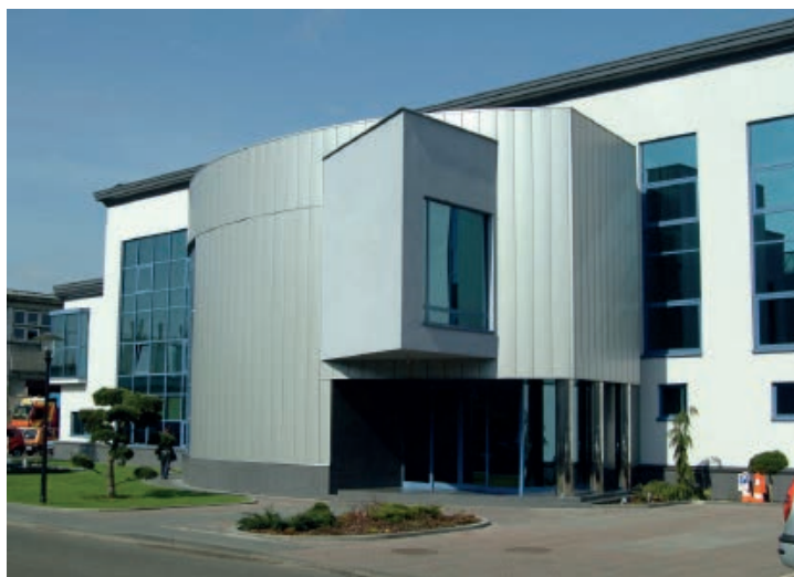
Rys. 1. Przykład elewacji wykonanej z pionowych paneli
