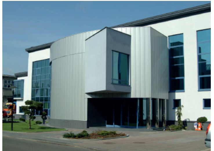
Abb. 1. Ein Beispiel für eine Fassade aus vertikalen Paneelen
